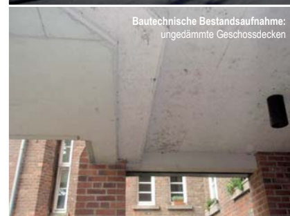
Bautechnische Bestandsaufnahme: ungedämmte Geschossdecken
